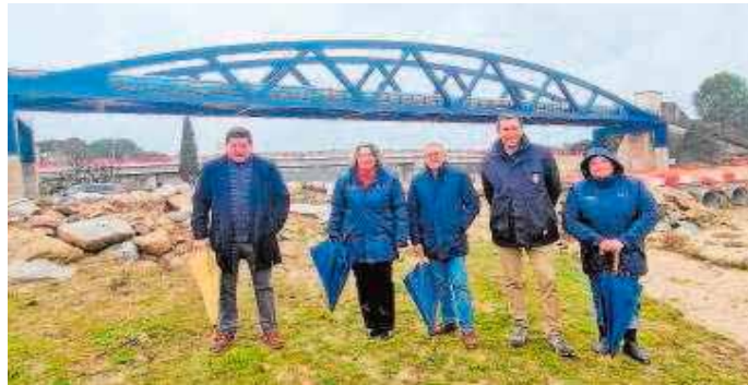
Mercedes Gómez visitó ayer las obras de reconstrucción de la tubería //JCCM
