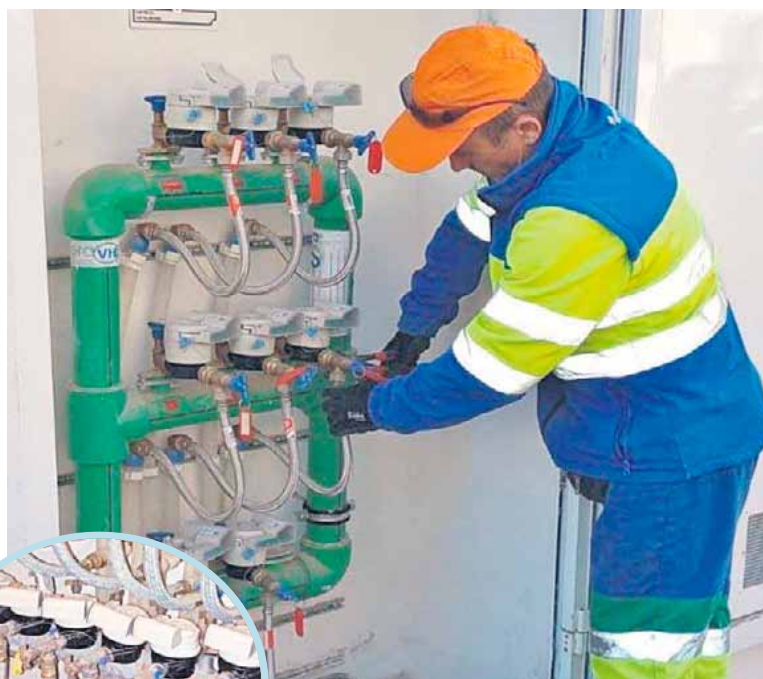
Un trabajador de Aqualia instala en Almería contadores inteligentes.
